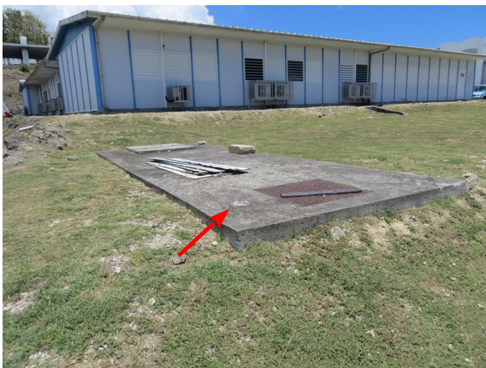
Figure 4 : photographie de la dalle en béton, avec en arrière plan la faculté des sports. Le repère en laiton est au centre de la photographie. Source : IGN.
